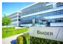
Zentrale der Baader Bank in Unterschleißheim bei München
